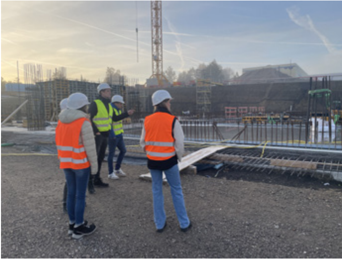
Mitarbeitende besichtigen den Baufortschritt des neuen Dynamikzentrums
