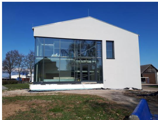
Sanierung und Modernisierung des Verwaltungsgebäudes Hafenstraße 19
