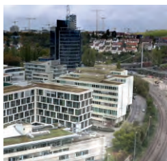
Hauptverwaltung 7 Ladestationen, 8 Fahrzeuge
