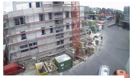
2: Neubau am Betriebsstandort in Vaihingen
