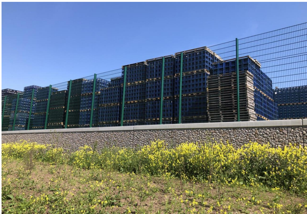
Neu errichtete Stützmauer
