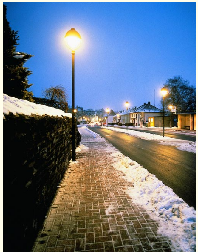
Energiesparende Kompaktleuchtstofflampen mit geringer Lichtpunkthöhe
