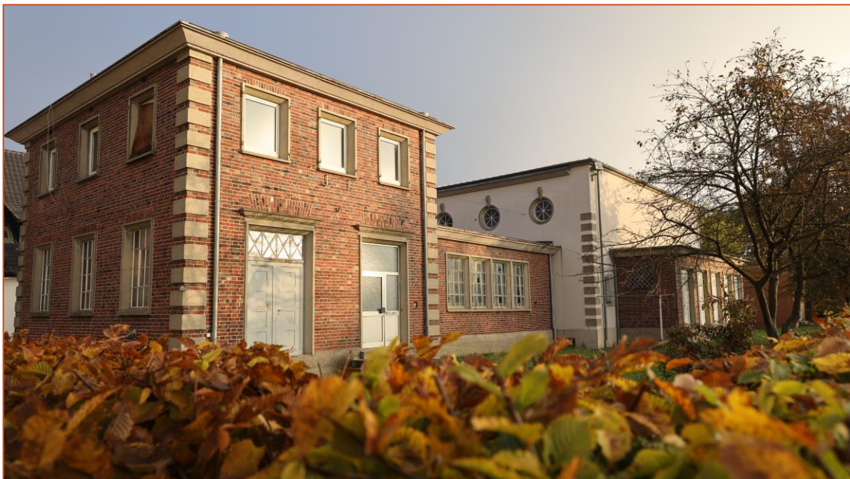
Abbildung 9: Gebäudeensemble des ehemaligen Umspannwerks in Friedrichshafen
