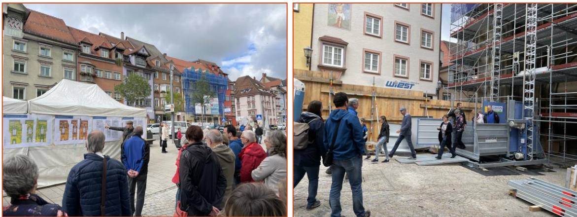
Abbildung 12: Projektvorstellung und Baustellenbegehung des Kapellenturms
