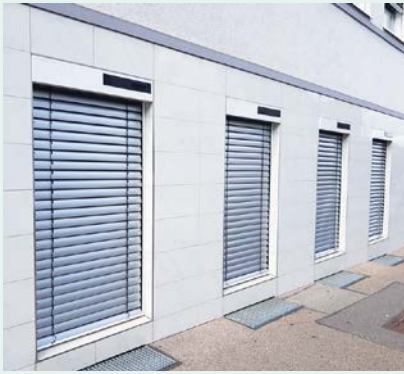
Solarbetriebene Jalousien im AOK-RückenStudio Waiblingen.
