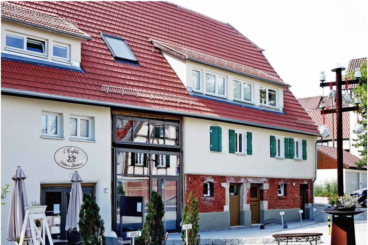
Fotografie der fertiggestellten Sanierung des Bachweberhofs, Hochdorf
