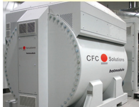
Dezentrale Kleinkraftwerke auf Brennstoffzellenbasis erzeugen kontinuierlich Strom und Wärme.
