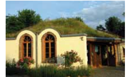
Foto: Ökostation Freiburg
